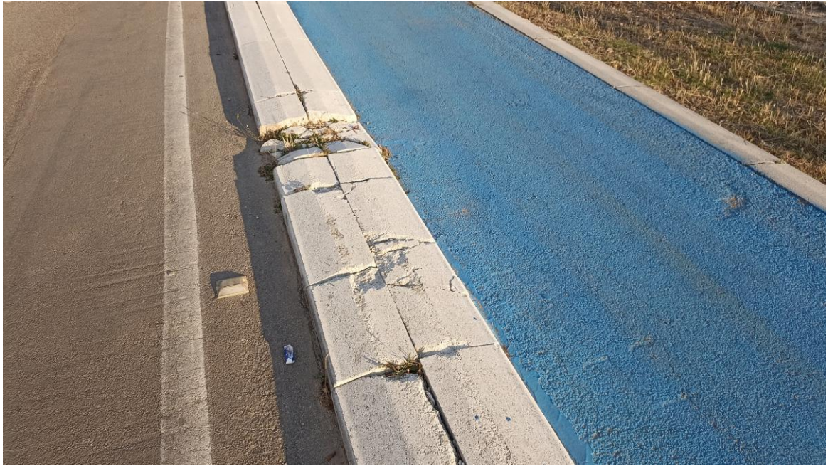
Figura 5 Particolare cordolo pista ciclabile
