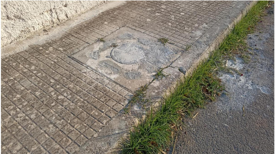
Figura 17 Stato di fatto marciapiede di Via Martiri di Belfiore
