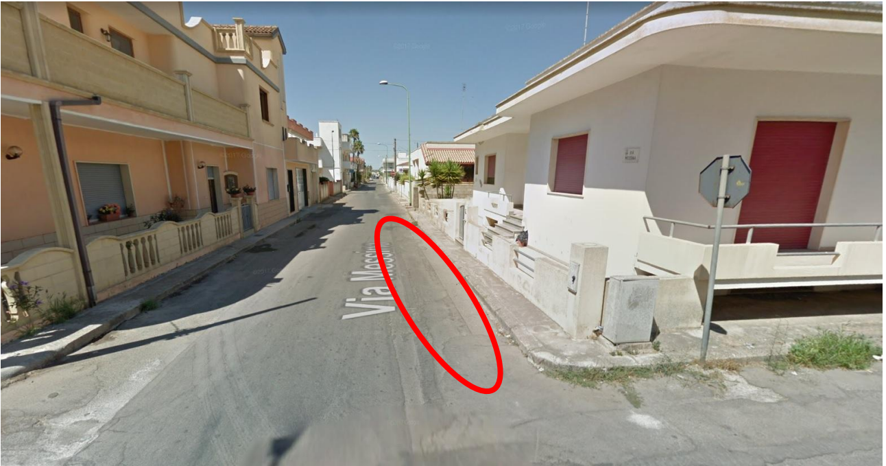
Figura 29 Stato di fatto sede stradale di Via Messina
