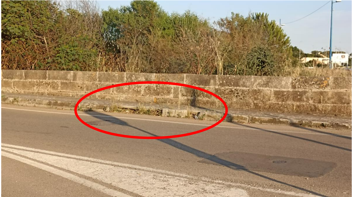
Figura 24 Stato di fatto marciapiede Via Curtatone
