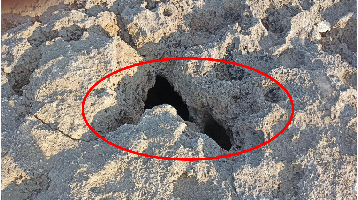
Figura 27 Stato di fatto soffione n. 3
