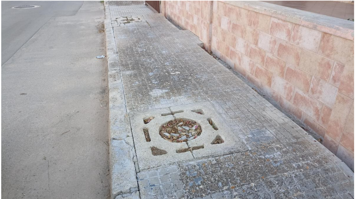
Figura 14 Stato di fatto marciapede Via Adua
