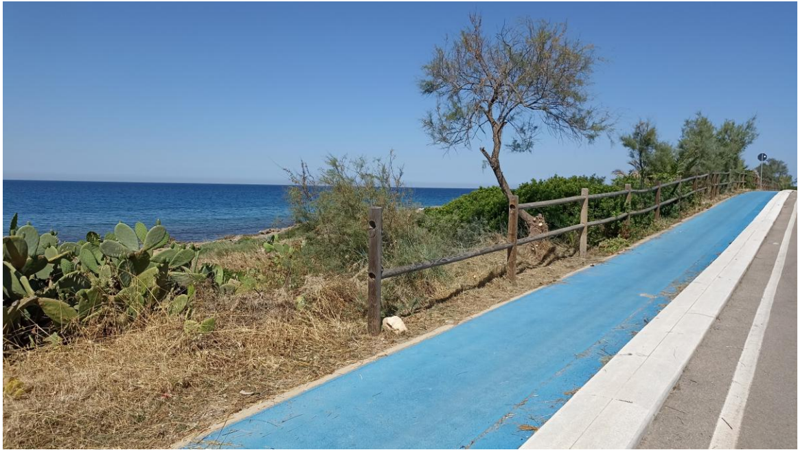
Figura 7 Stato di fatto staccionata Corso Vittoria
