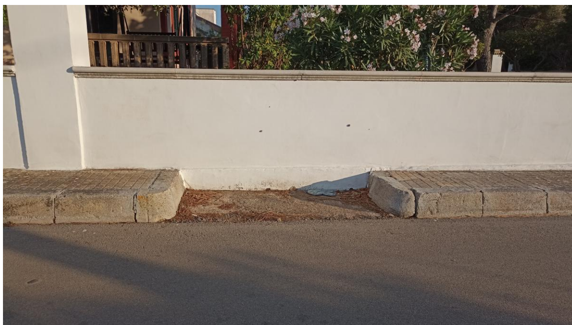
Figura 21 Stato di fatto marciapiede Via Thaon de Ravel
