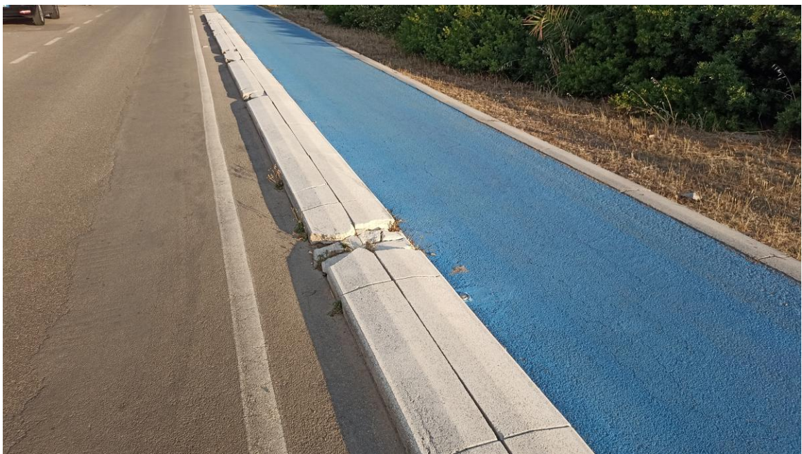
Figura 6 particolare cordolo pista ciclabile
