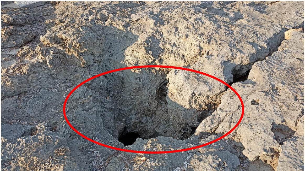
Figura 28 Stato di fatto soffione n. 4
