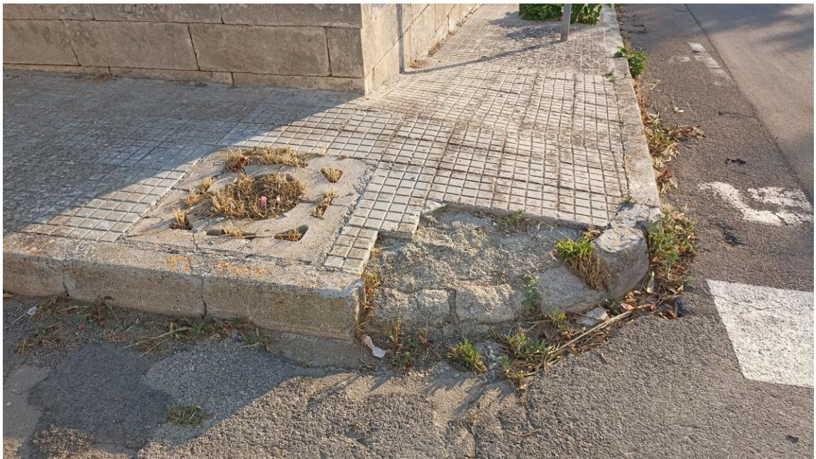
Figura 15 Stato di fatto marciapede Via Adua
