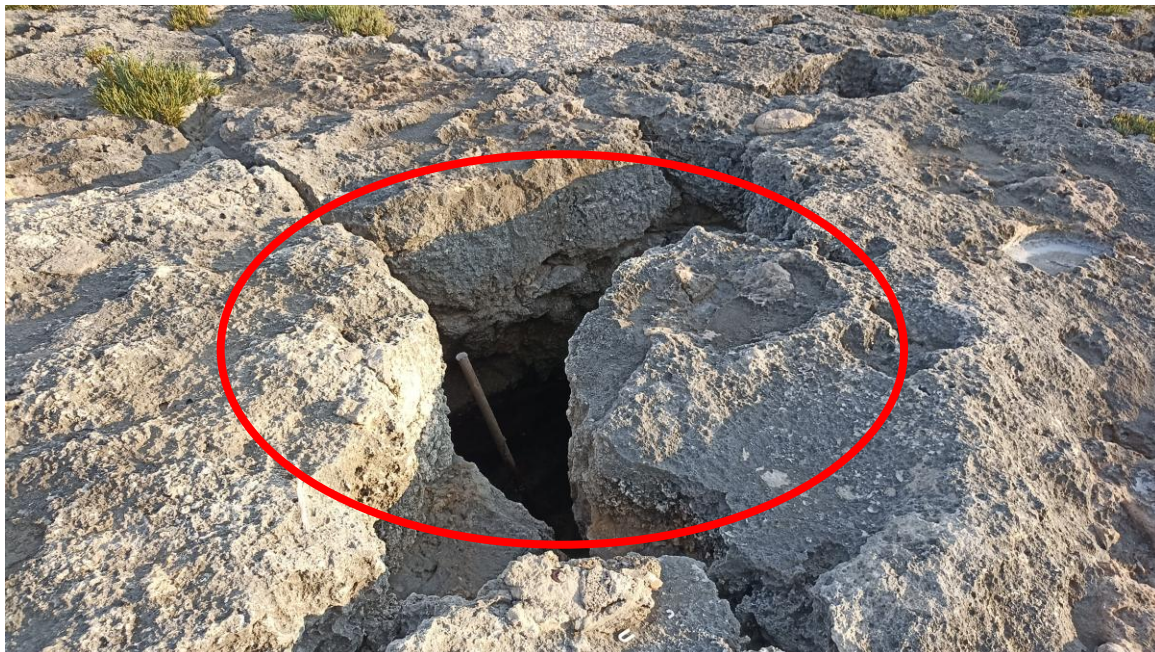
Figura 25 Stato di fatto soffione n. 1
