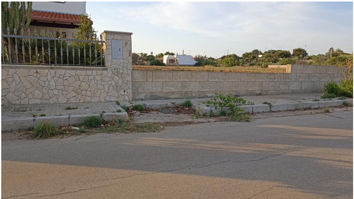
Figura 18 Stato di fatto marciapiede di Via Martiri di Belfiore
