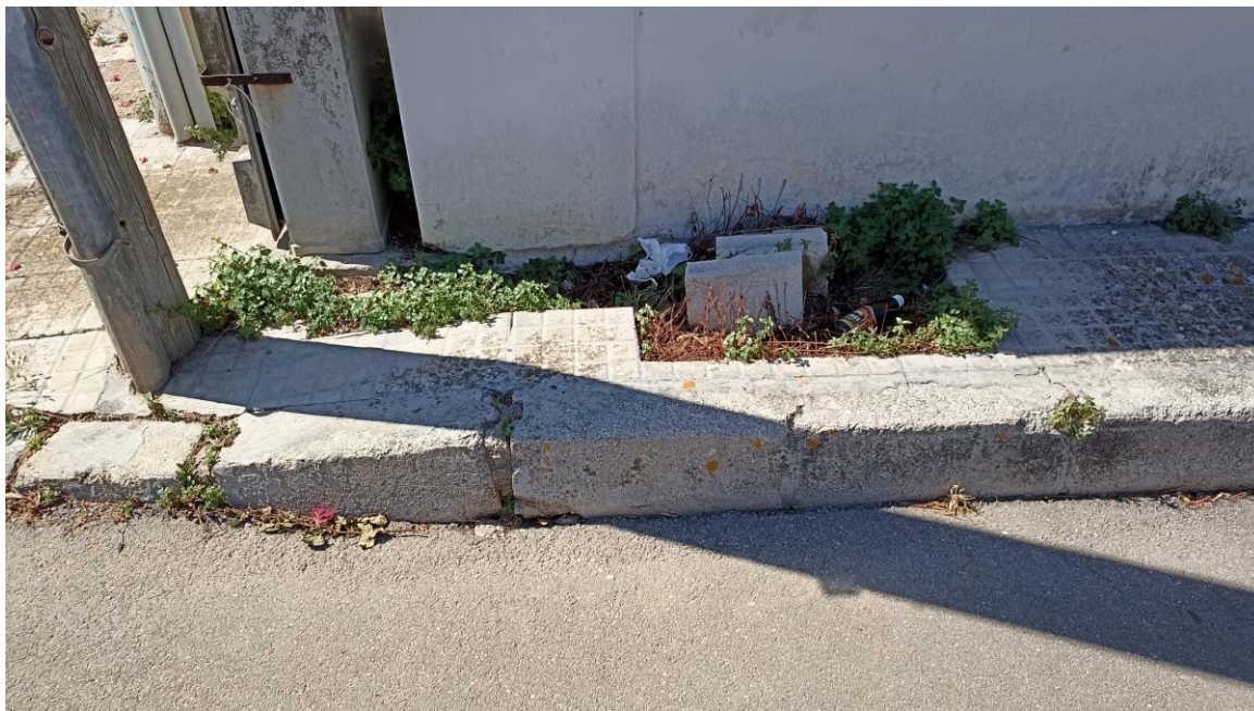
Figura 20 Stato di fatto marciapiede Via Thaon de Ravel
