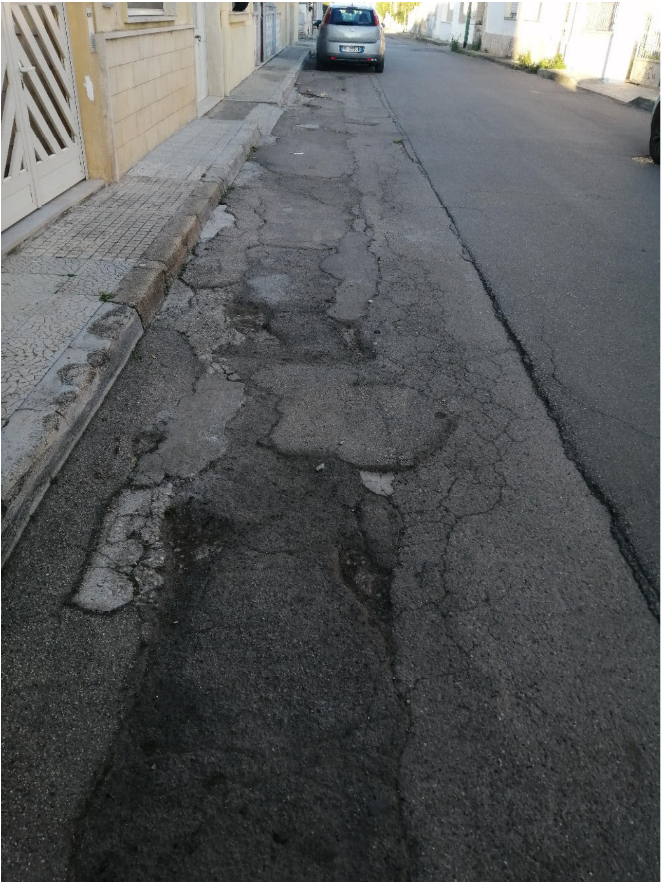
Figura n. 20 via Marsala ID 9
