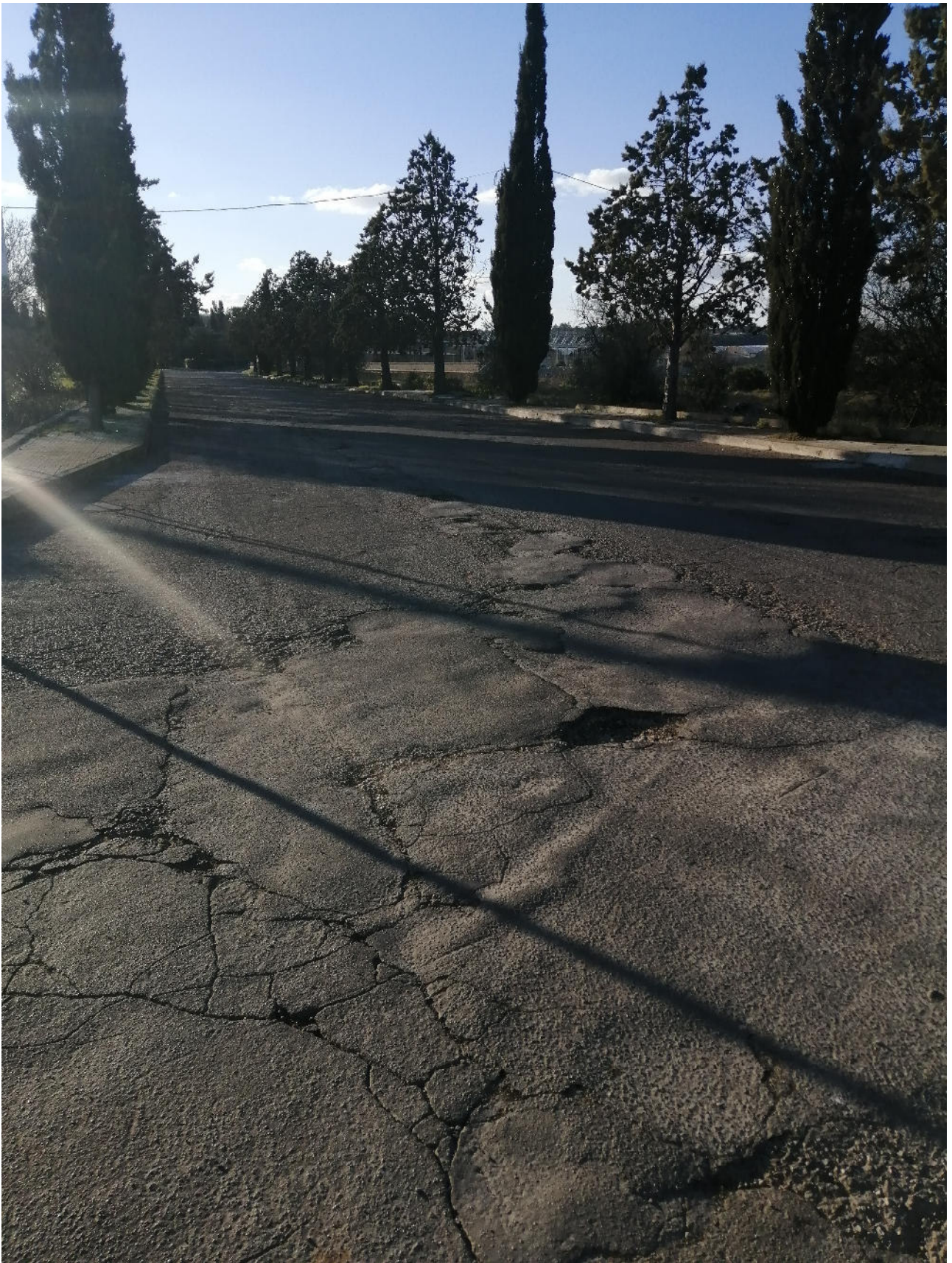
Figura n. 1 viale cimiteto ID 1
