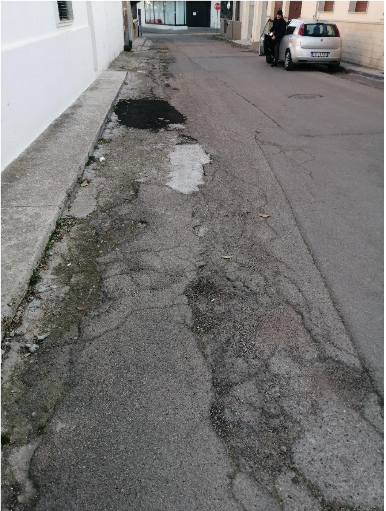
Figura n. 28 via Piemonte ID 14
