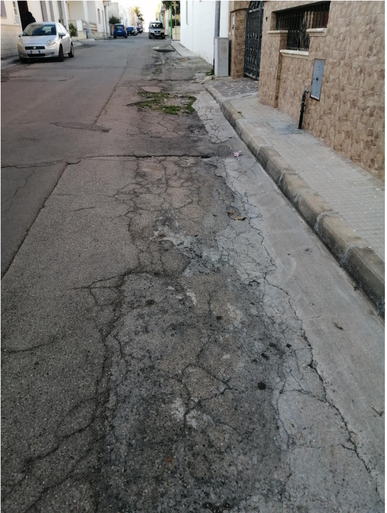
Figura n. 29 via Piemonte ID 14
